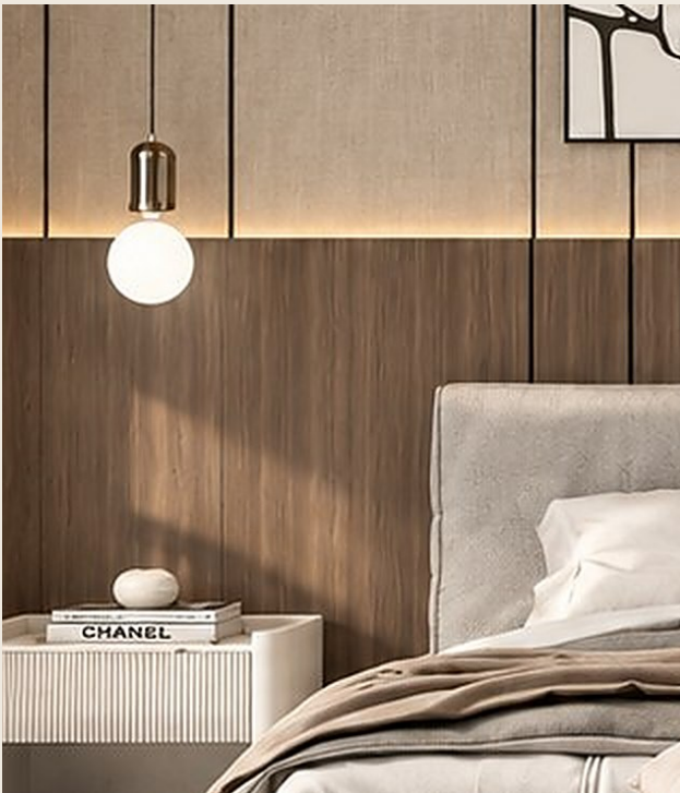
Junta de sombra — el lino y el nogal se encuentran con una ranura de 10 mm que aloja la línea de LED.
