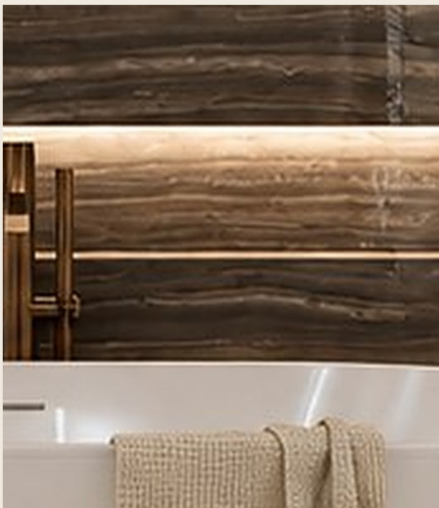
Grifería de latón cepillado — monomando de piso y nicho lineal retroiluminado a 110 cm.
